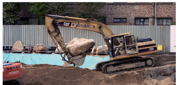
19. 発掘時の巨礫の除去 (297地点) 通常よりも一回り大きい重機を使うことになった。
